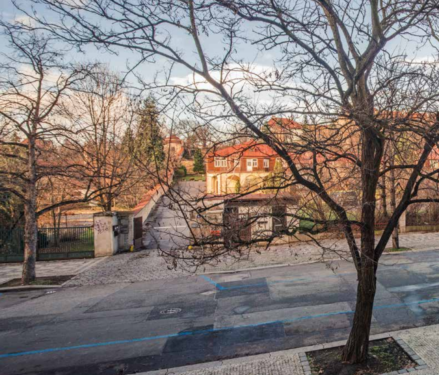
Místo výstavby budoucího Biocentra. / Place of construction of the future Biocenter.
