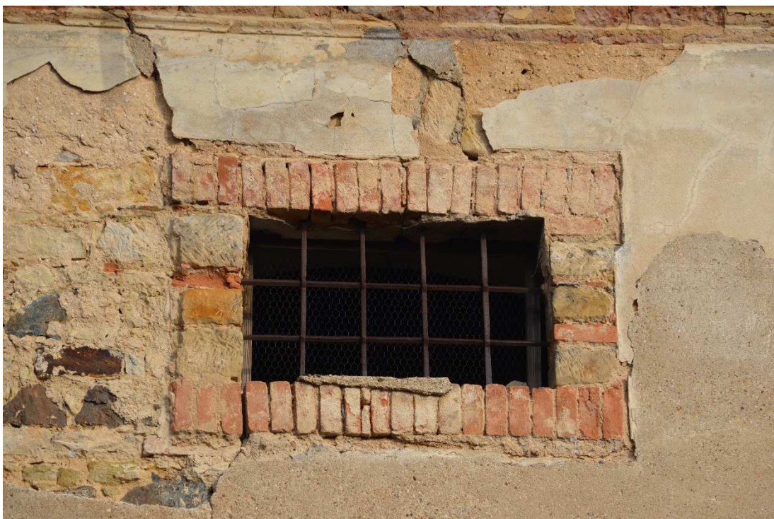
20. Detail okna jižní fasády, se zaniklou omítkovou šambránou.
