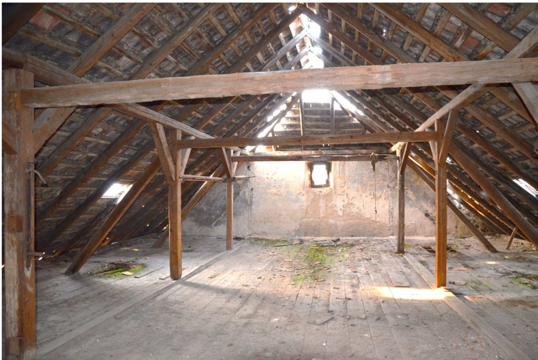
91. Krov, pohled k západnímu štítu.
