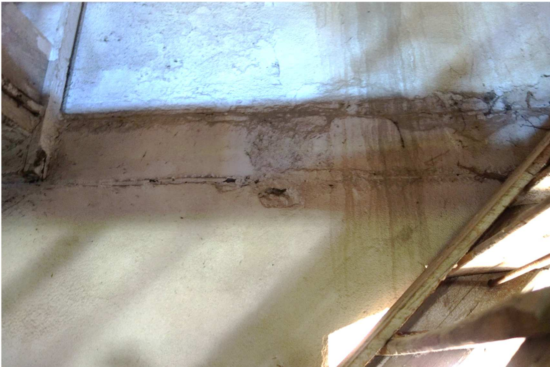
80. První patro, pohled na původní lůžko zkráceného stropního trámu nad schodištěm.
