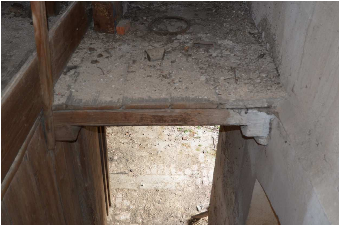
63. Pohled na okosený stropní trám přízemí nad schodištěm.
