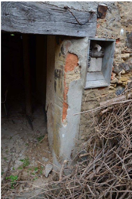
8. Vjezd ve střední ose jižní fasády, pískovcová stojka osazená za líc fasády a překrytá plentou s cementovou omítkou.
