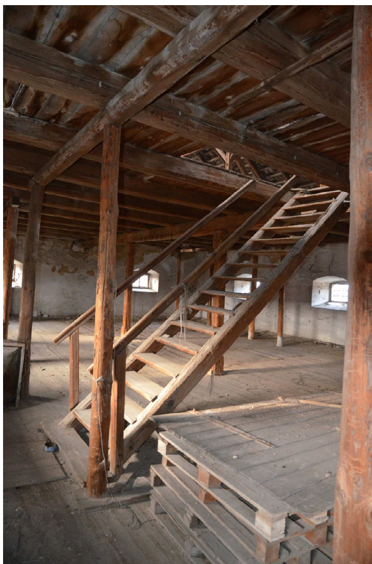
86. Druhé patro, pohled na schodiště ve střední ose jižně středního průvlaku.
