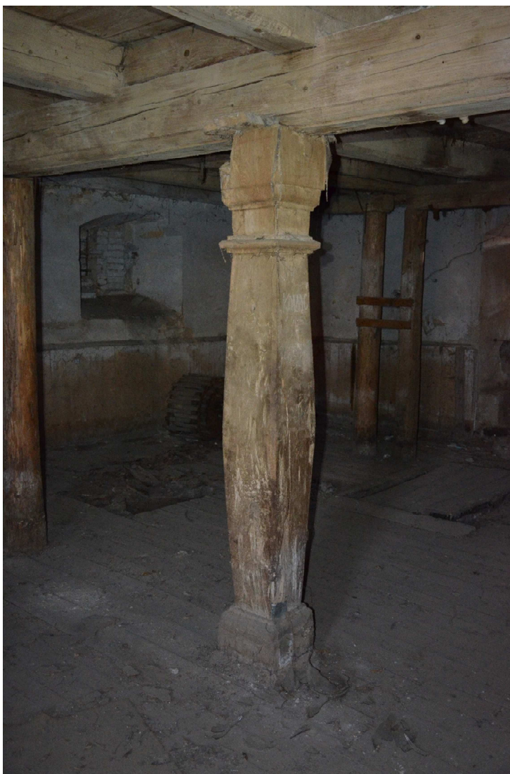
48. Interiér přízemí, dubový sloup středního průvlastku (první od východu).
