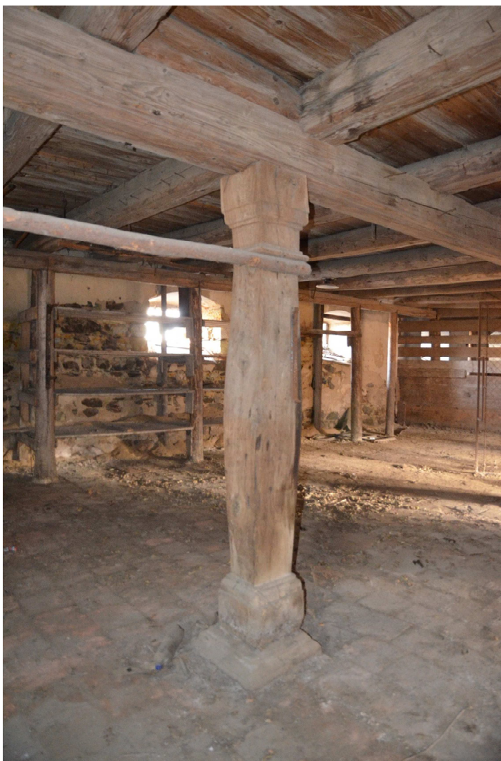
49. Přízemí, dubový sloup středního průvlastku (první od západu).
