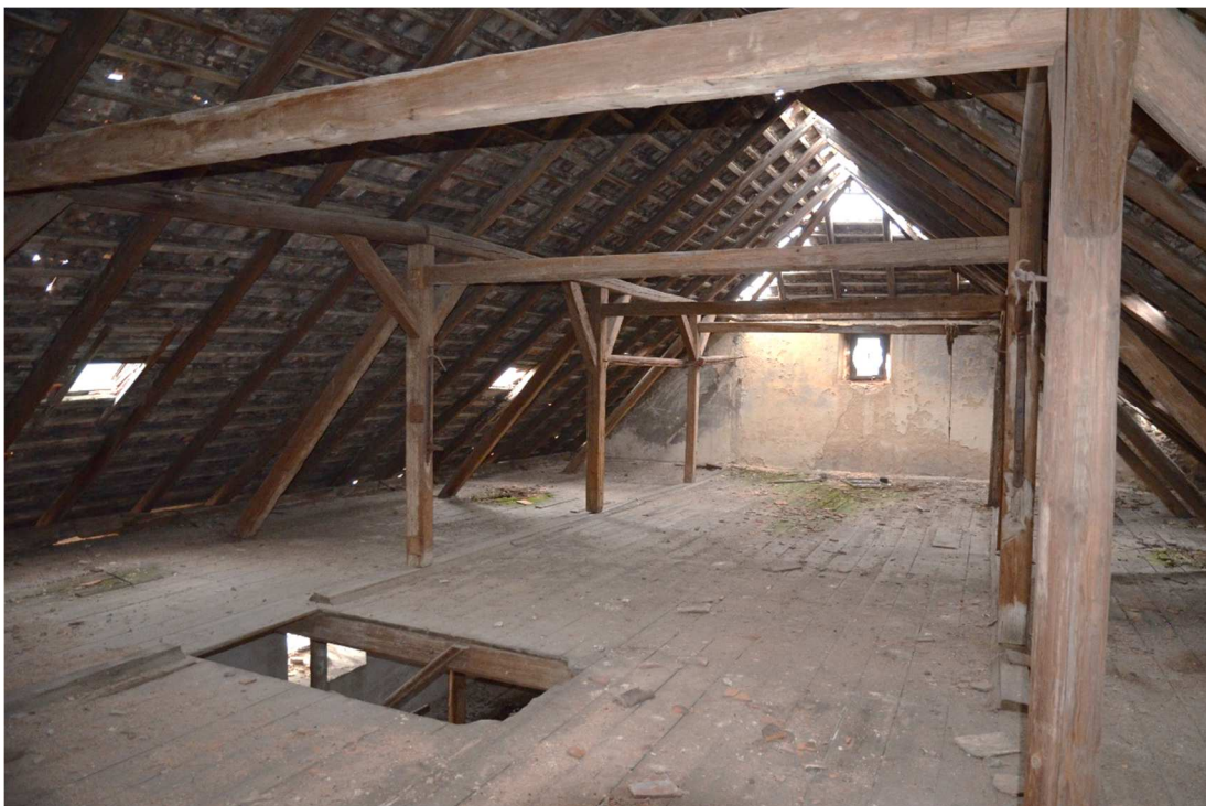
92. Krov, pohled k jz. s ústím schodiště z druhého patra.
