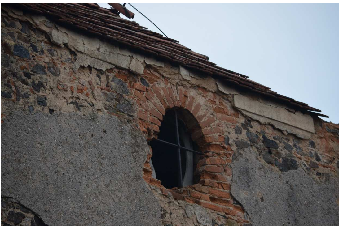
31. Oválné okno západního štítu se zaniklou šambránou. V okně původní mříž, nad oknem pozdně barokní pásový profil.
