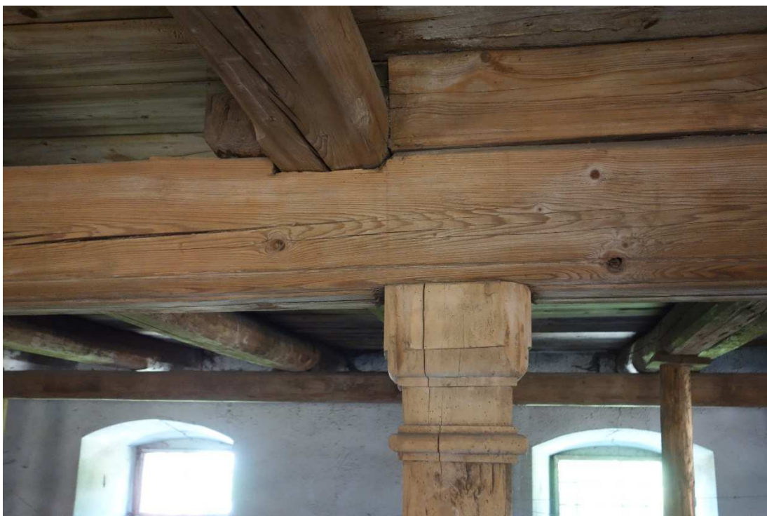
72. První patro, detail připojení sloupu a stropního trámu ke střednímu průvlaku.
