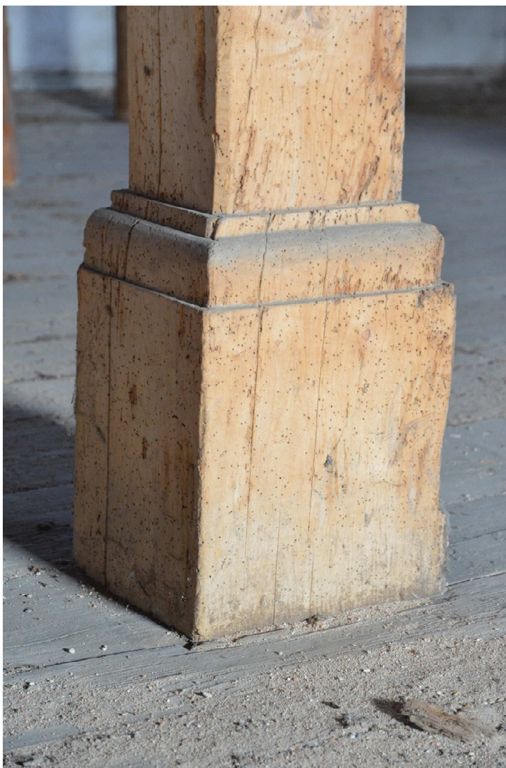
74. První patro, dubový sloup středního průvlaku, detail patky.
