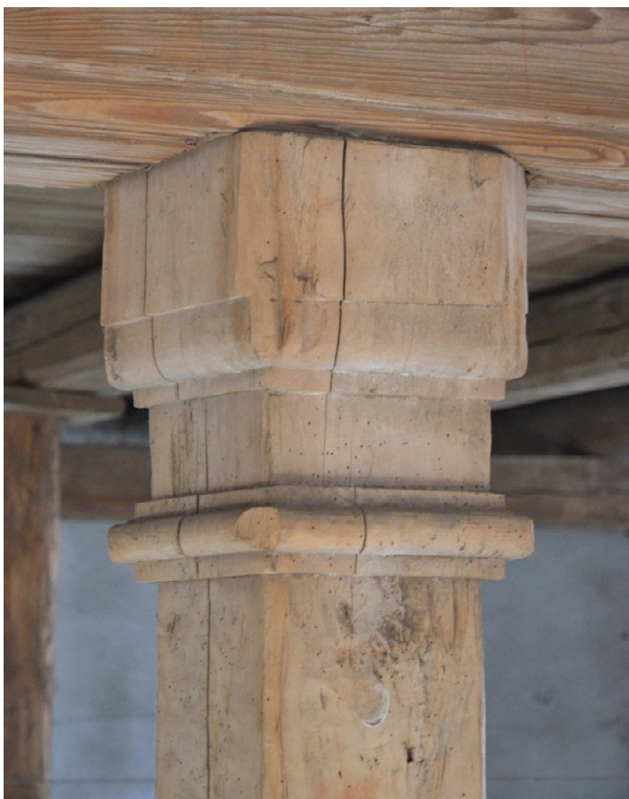
73. První patro, dubový sloup středního průvlaku, detail hlavice.
