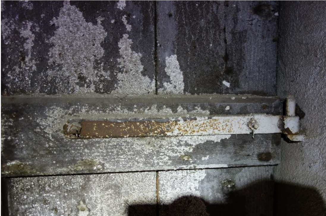
14. Dvoukřídlá výplň nakládacího otvoru v patře jižní fasády, pohled z interiéru, detail.
