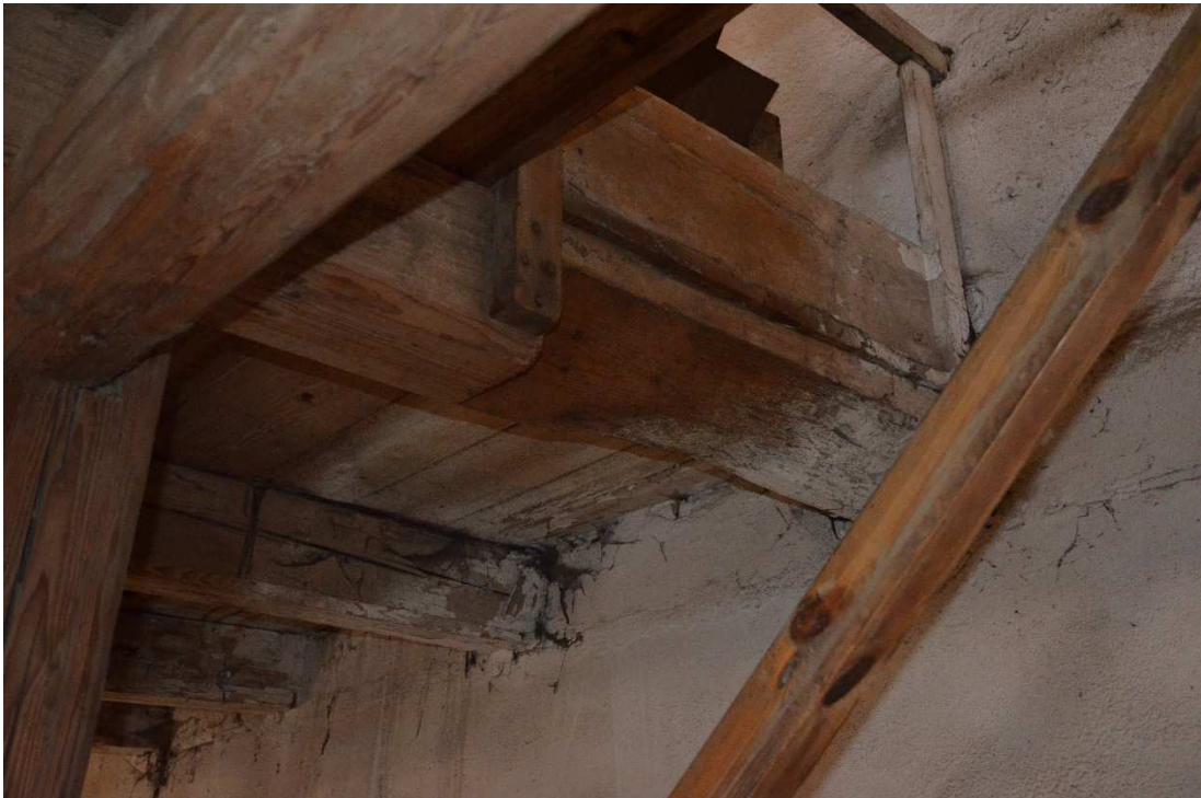
79. První patro, schodiště, detail okosení stropního trámu.
