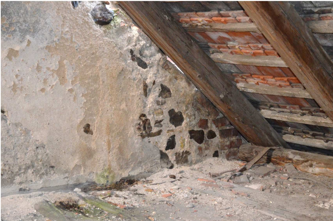
101. Krov, sz. nároží, detail skladby zdiva na konci severního křídla štítu.
