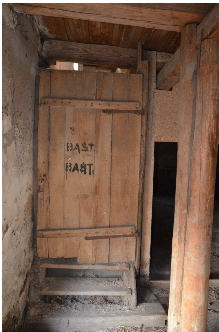
60. Přizemí, dveře schodiště do patra.
