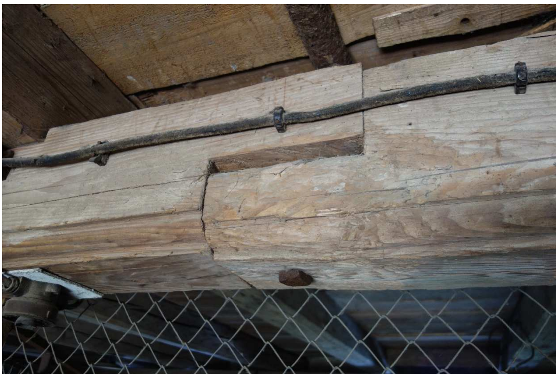
53. Přizemí, detail napojení středního průvlaku. Při spodním okraji ozdobný profil.
