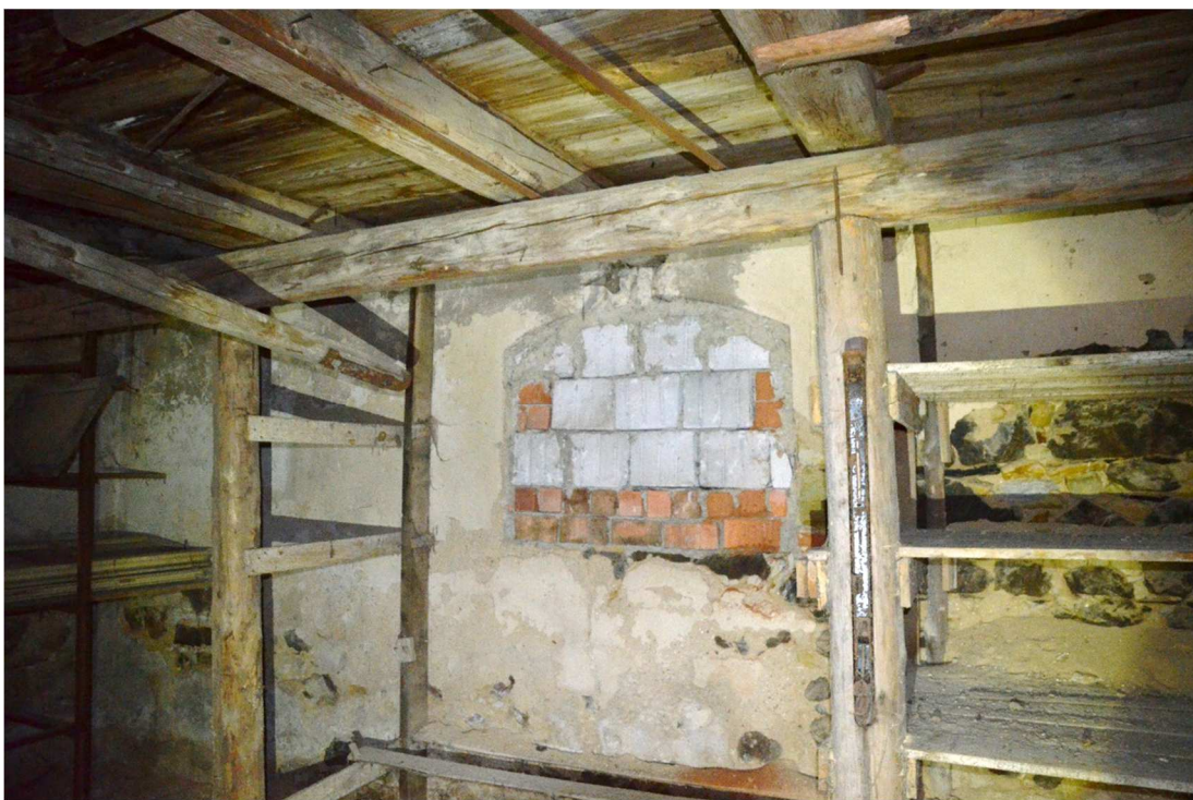
57. Interiér přízemí, pohled na novodobou zadržku západního okna severní fasády.
