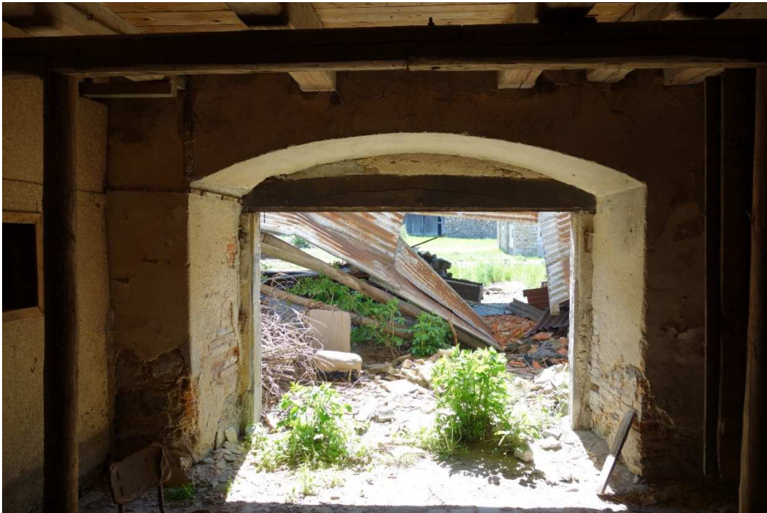
7. Vjezd ve střední ose jižní fasády, pohled z interiéru.
