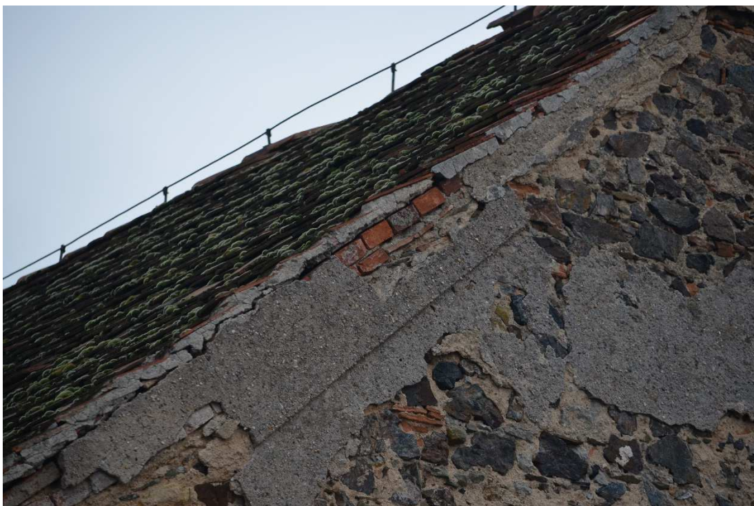
30. Západní štít, detail mladší cihlové nadezdívky s druhotnými omítkami.
