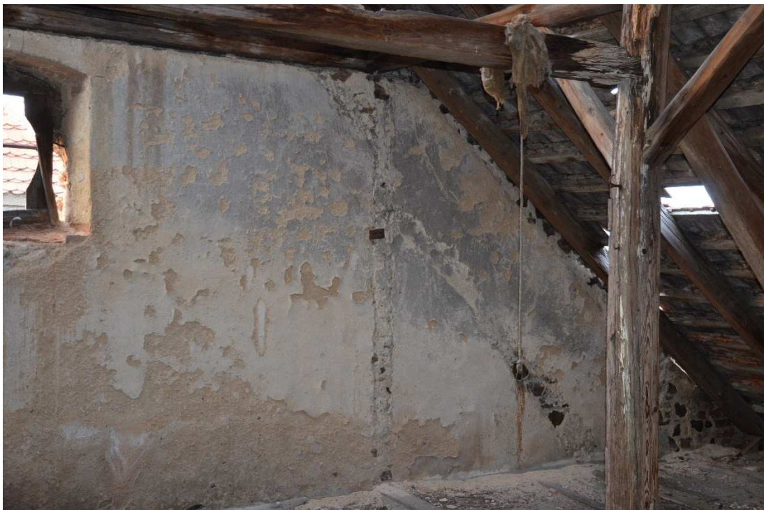
100. Krov, sz. nároží, otisk starší konstrukce v omítce západního štítu.
