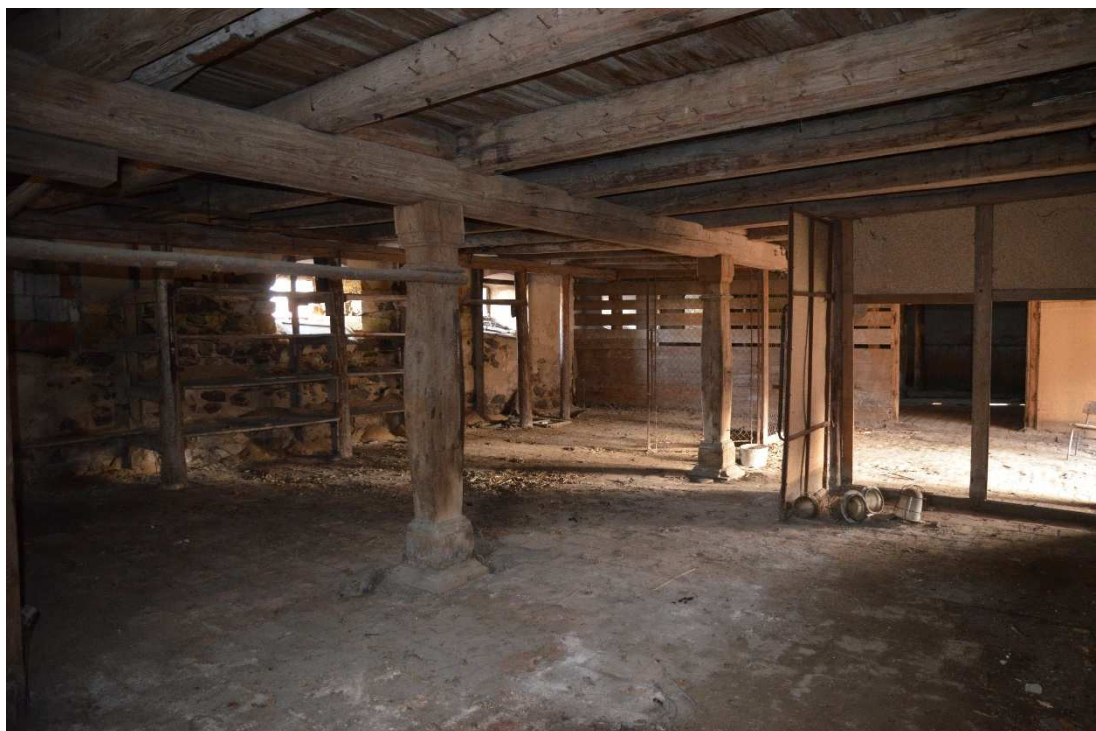
46. Interiér přízemí, pohled na střední průvlak, na podlaze cihlové dlaždice v západní polovině objektu.
