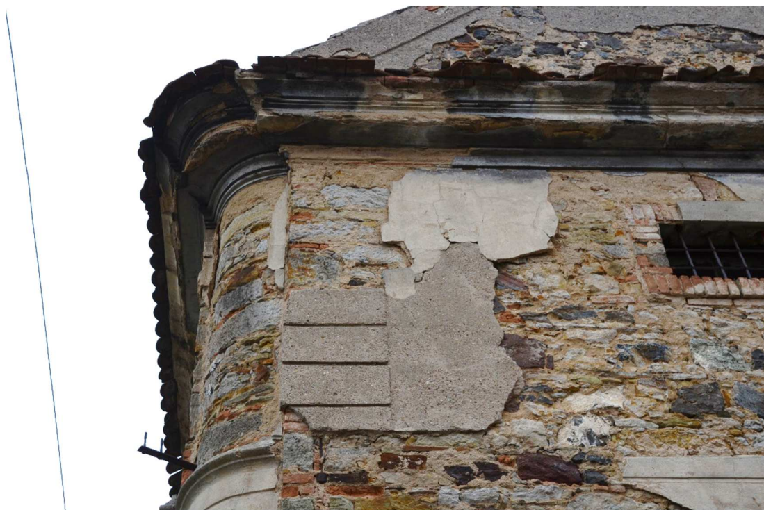
32. Západní fasáda, detail napojení omítek a rekonstruované bosáže při sz. nároží.
