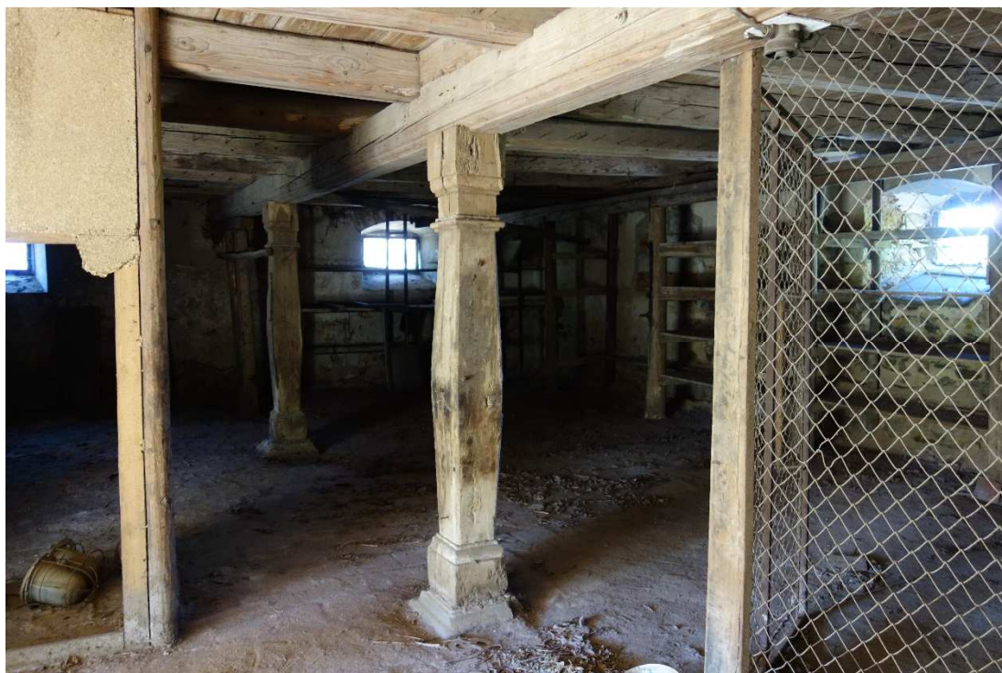
47. Přízemí, pozdně barokní střední průvlak se sloupy, pohled od vjezdu směrem k západu.
