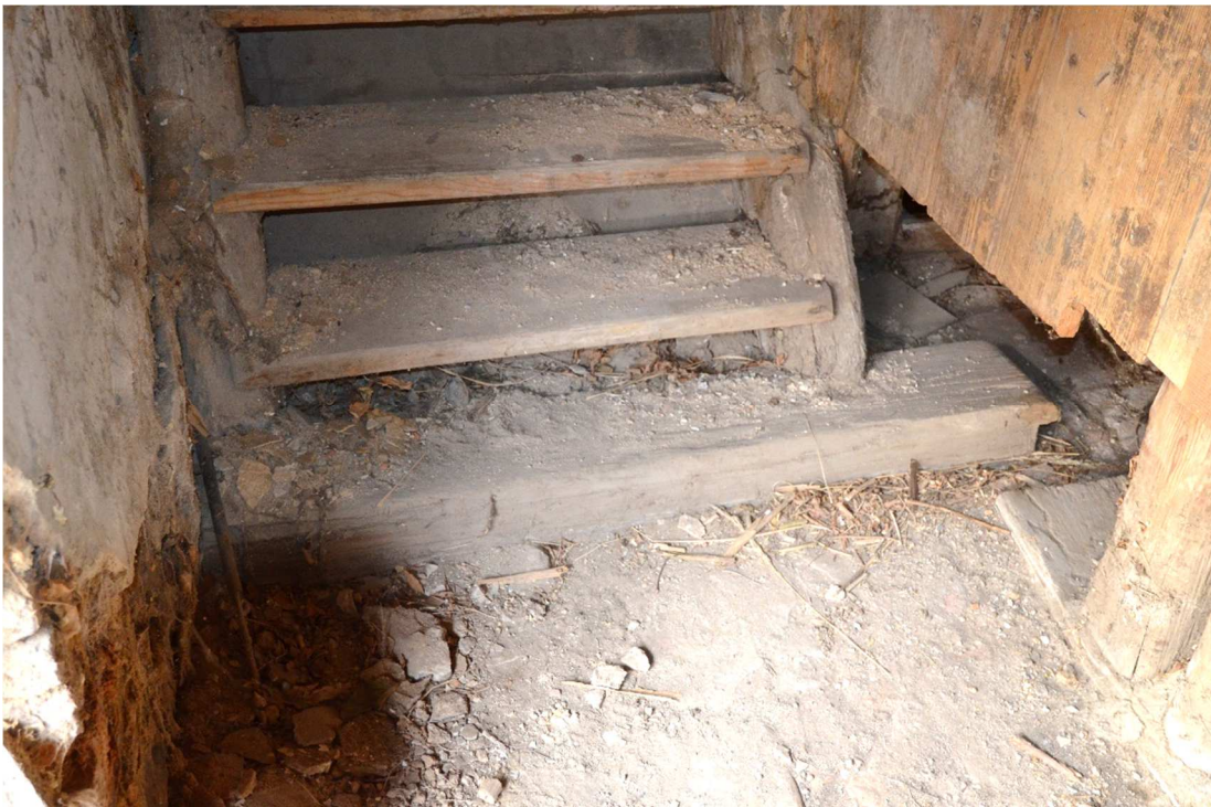
62. Přízemí, detail schodiště s odlišně řešeným prvním stupněm.
