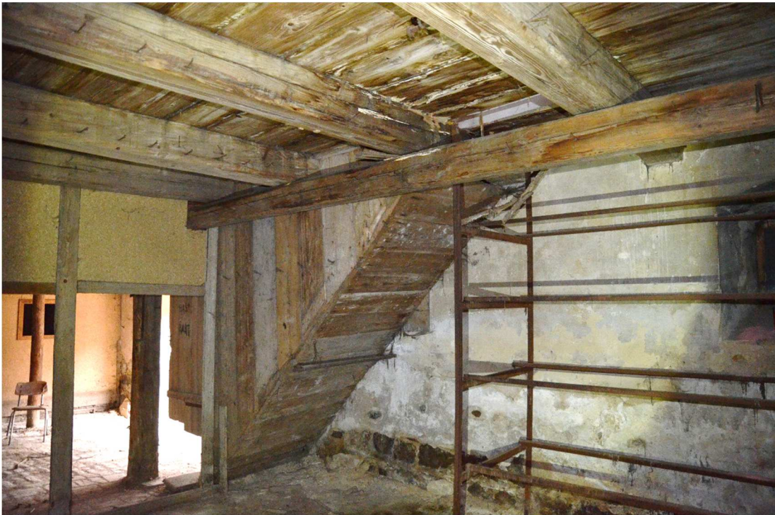
61. Přízemí, pohled na bednění schodiště.
