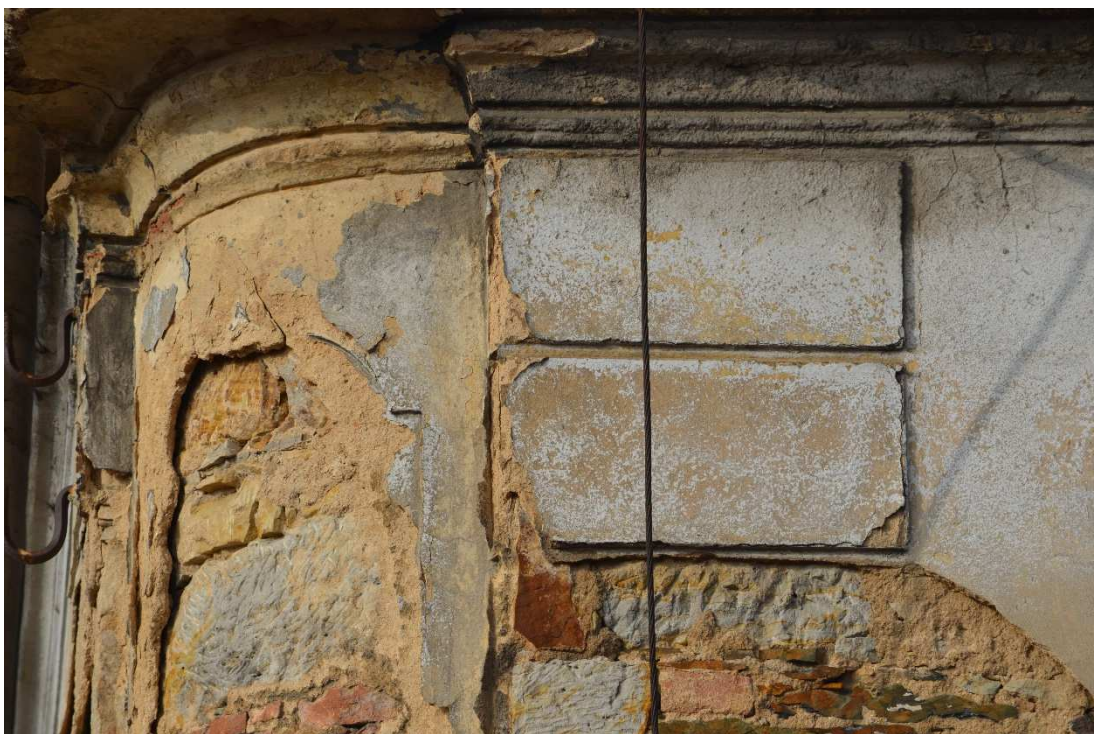
40. Východní fasáda, detail jv. nároží pod hlavní římsou s fragmenty šedého nátěru.
