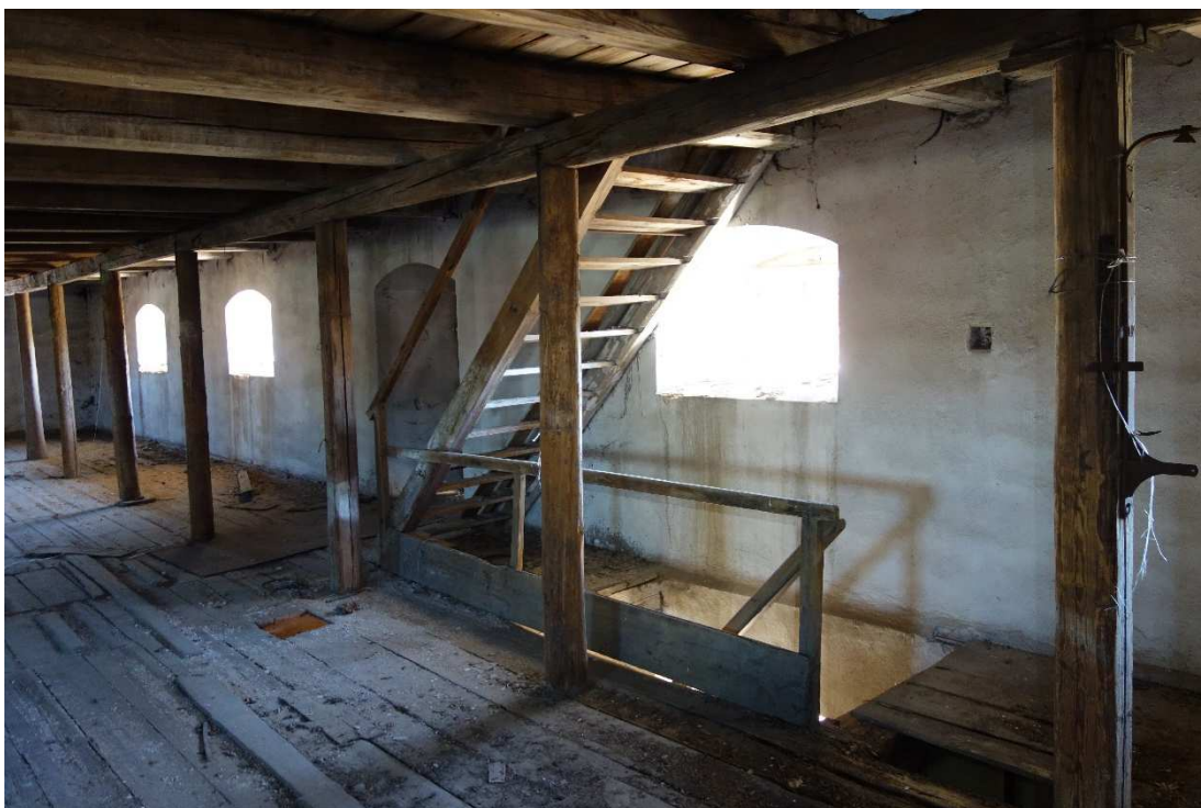
81. První patro, pohled na schodiště od sz.
