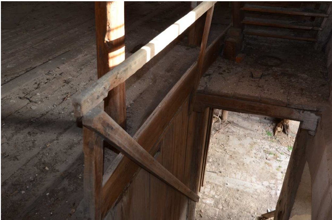
64. Detail zábradlí schodiště mezi přízemím a prvním patrem.
