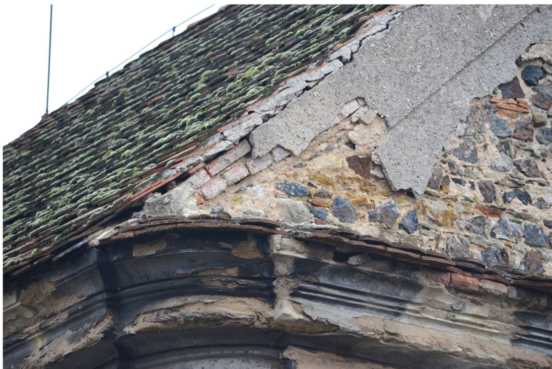
29. Západní štít, detail mladší cihlové nadezdívky s druhotnými omítkami.
