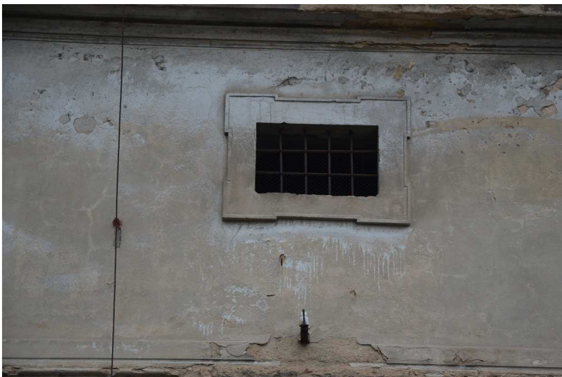
38. Severní fasáda, detail okna s dochovanou šmabránou.
