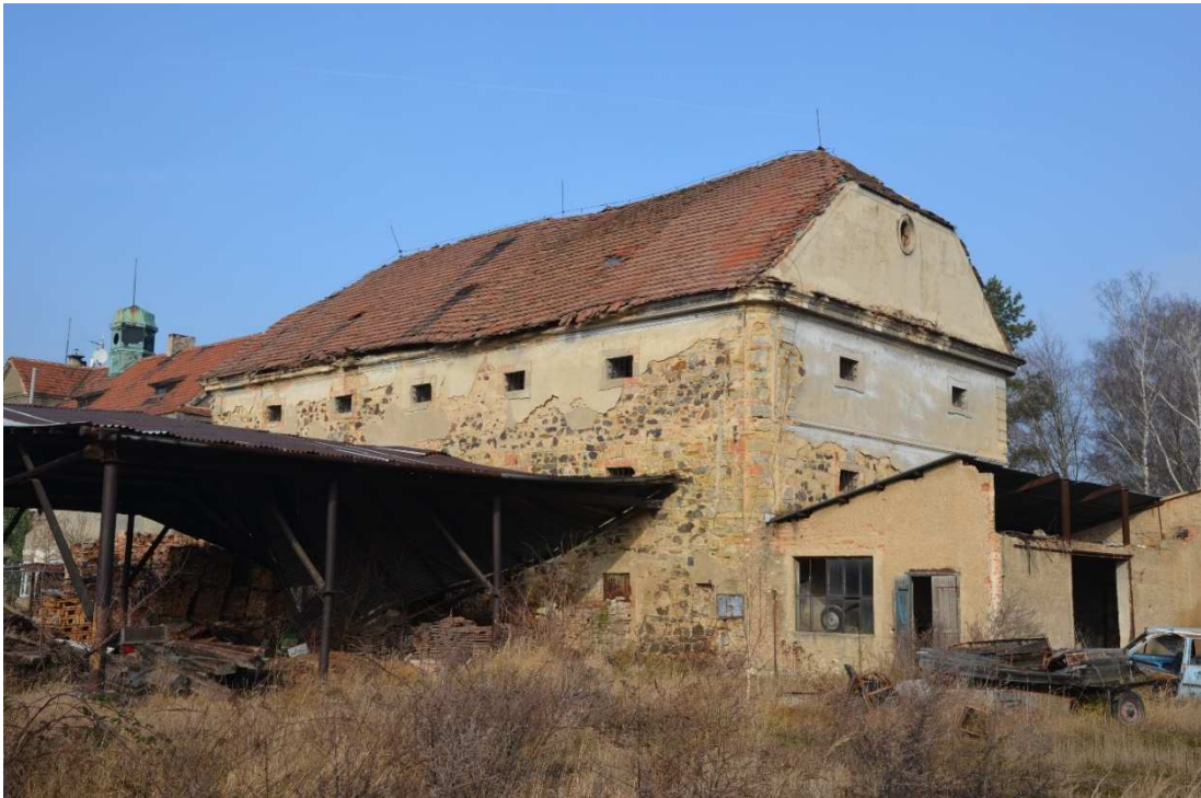
1. Pohled na sýpku od jihovýchodu, při fasádách novodobé přístavby.
