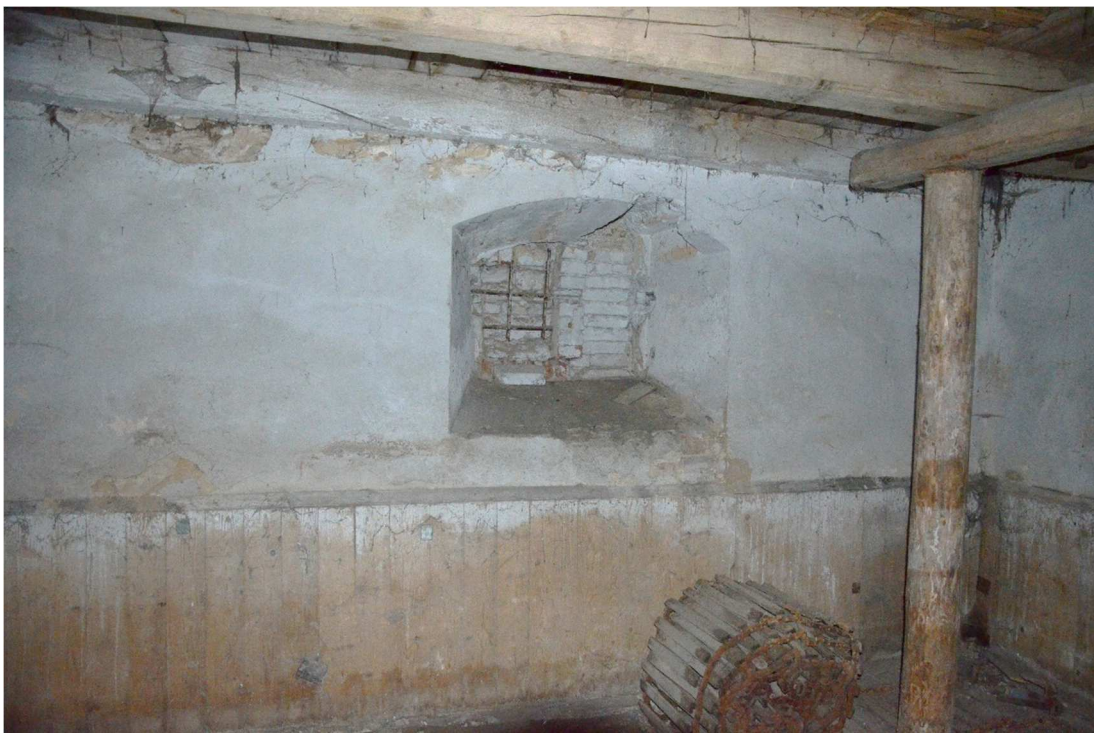
58. Zazděné okno v přízemí v jižní ose východní fasády. Pod oknem palubkový obklad.
