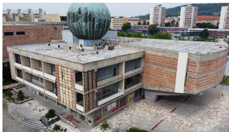
Probíhající rekonstrukce kulturního domu Repre, 2025
