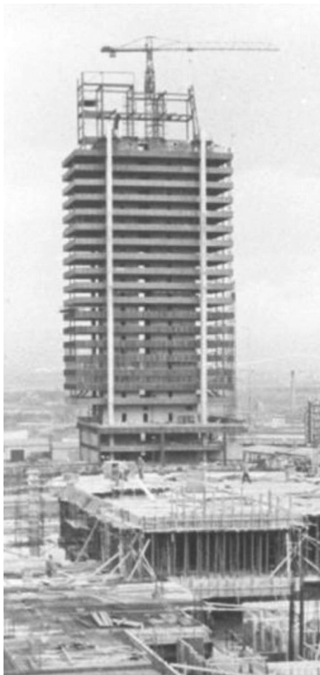
Stavba SHD, 1970–1984, autoři Václav Krejčí, J. Fojt, Míša Hejduk, v popředí stavba OD Prior
